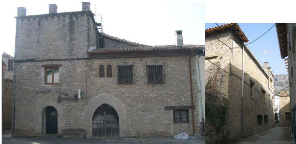
Fachada principal, norte
