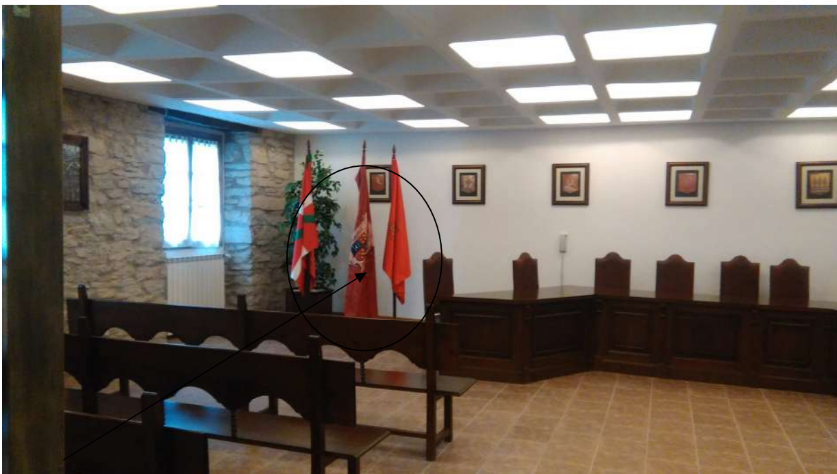
Salón de plenos donde se va a abrir hueco de comunicación
