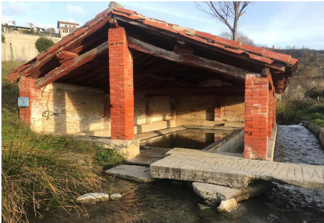
Fachada principal con los tres pilares a demoler y la cubierta de teja y estructura de madera
