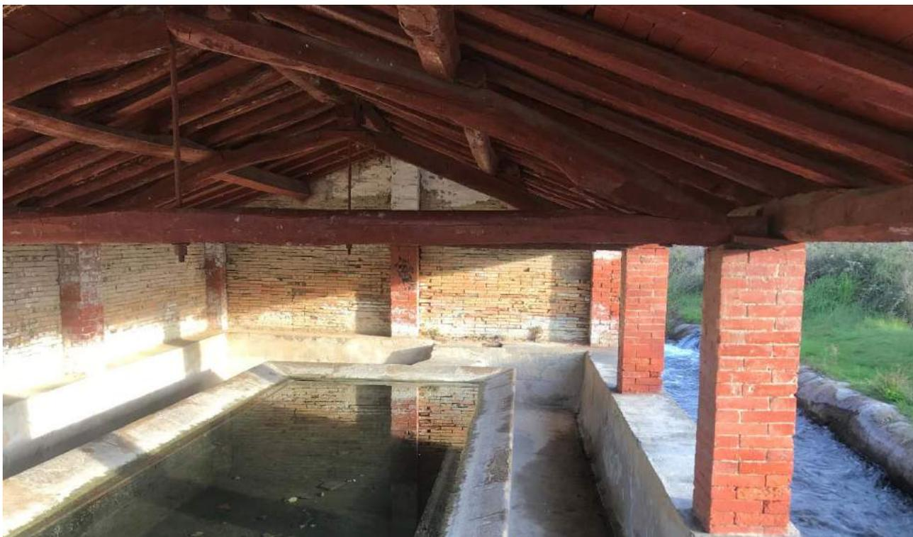
Estructura de madera de la cubierta que será desmontada
